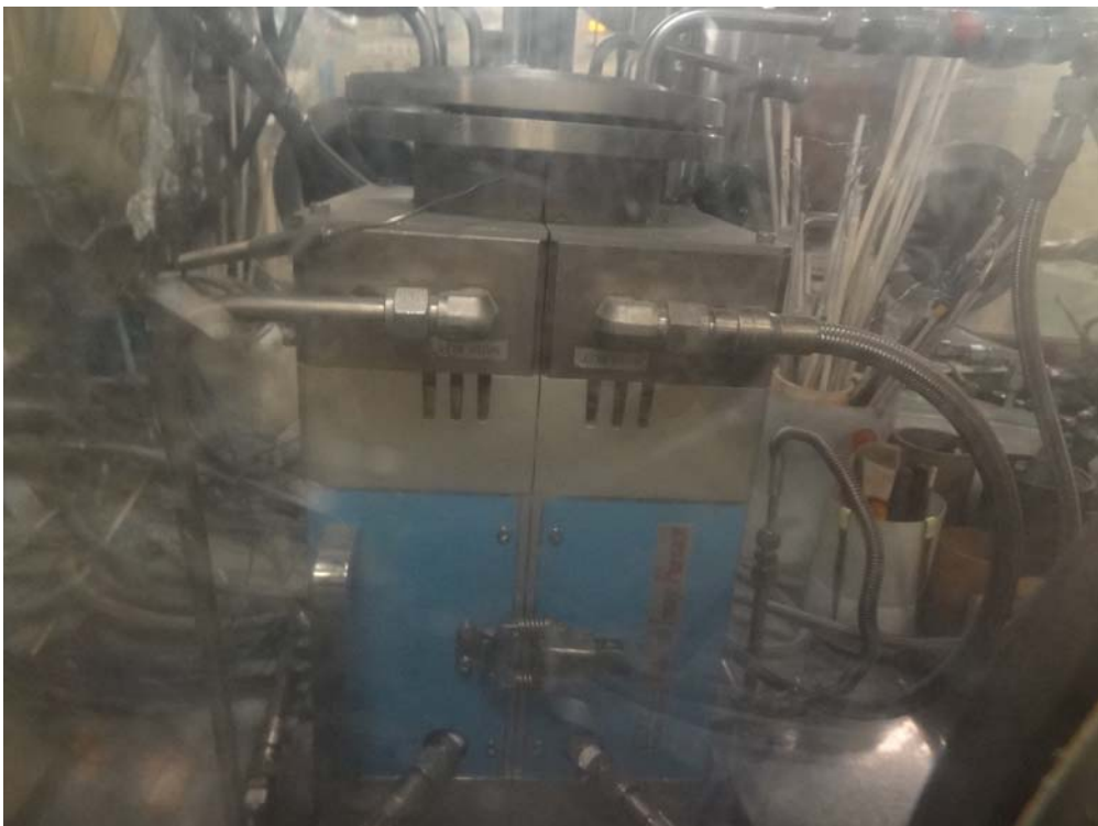
GB : 1 1 4 -D (電解試験炉)【作業スペースの確保不可】
